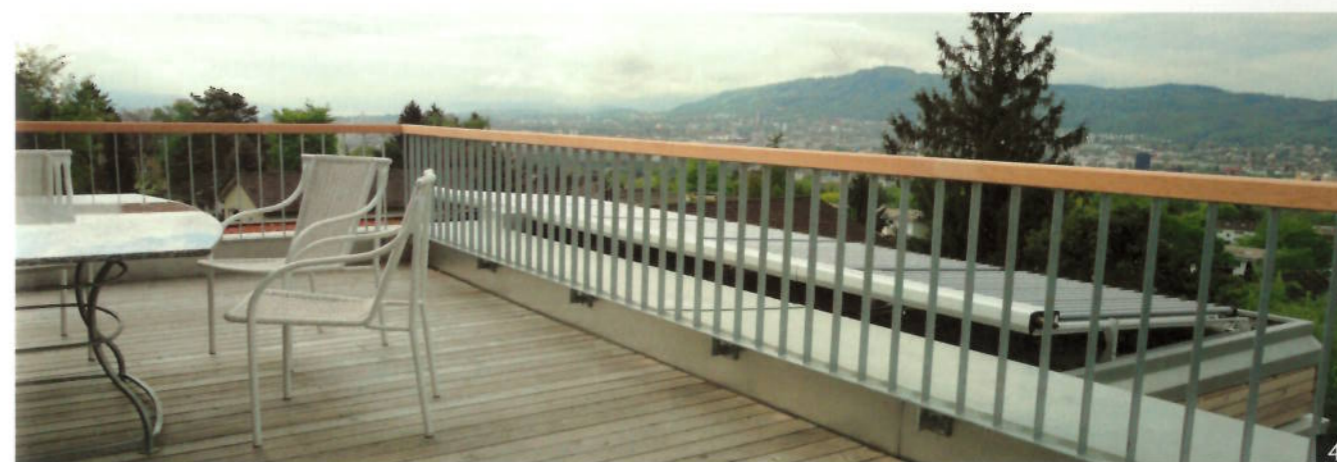
1: Das neu sanierte Mehrfamilienhaus wurde durch Beat Kämpfen von einer Energieschleuder zu einem Nullheizenergiehaus umgebaut.
