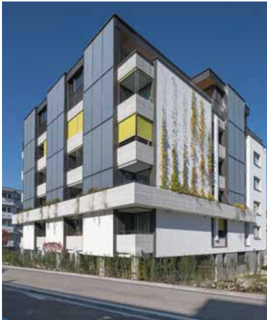
Die 50 Kleinwohnungen des Umbaus in Schwamendingen brauchen viel Warmwasser. Die Sonnenkollektoren erwärmen es.
