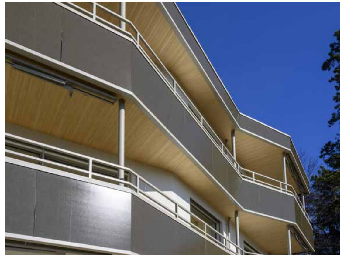
Beim Neubau in Höngg produzieren Fassaden und Dach elektrischen Strom. Die Sonne liefert mehr als benötigt.
