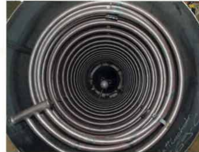
11 Der hypnotisierende Blick in den 19 m hohen Solarschichtspeicher verrät etwas von dem Innenleben: Man erkennt die Wärmetauscherschlangen und ganz hinten den integrierten Warmwasserboiler.
