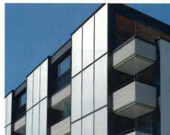
12 Insgesamt 180 m 2 Solarthermiekollektoren sind an den Fassaden installiert – allein 109 m 2 auf der Südfassade.
