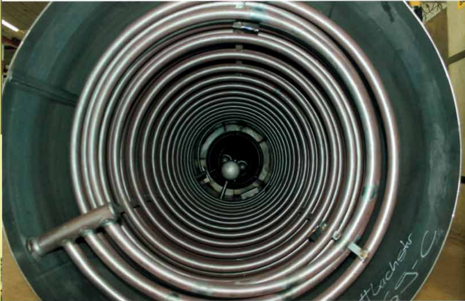
Der Blick in das Innere des Tanks (oben). Die Aufstockung wurde in Holz erstellt und die Wohnungen sind auch in Holz ausgekleidet mit grünen Farbelementen. Die Konstruktion in Holz ist wesentlich leichter und verlangte darum keine Verstärkung der bestehenden Konstruktion.
