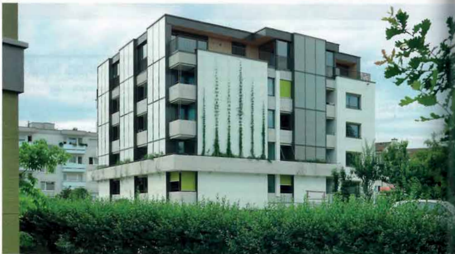
In Zürich-Schwamendingen gibt es die schweizweit erste Minergie-A-Erneuerung.
