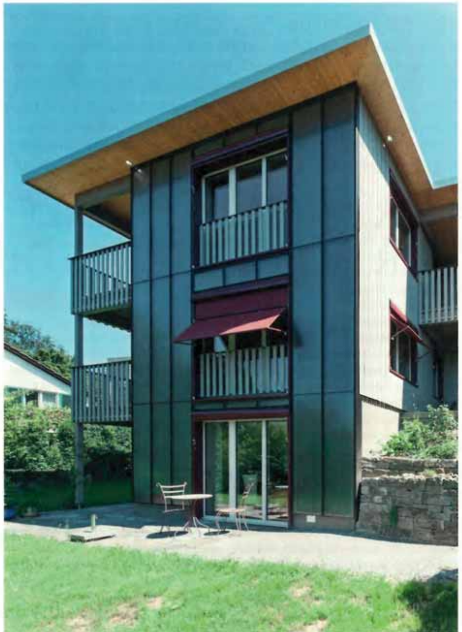
Die Anlage an der Eichhalde fügt sich dank farblich passenden, grauen Solargläsern optimal ins Erscheinungsbild des Gebäudes ein.
