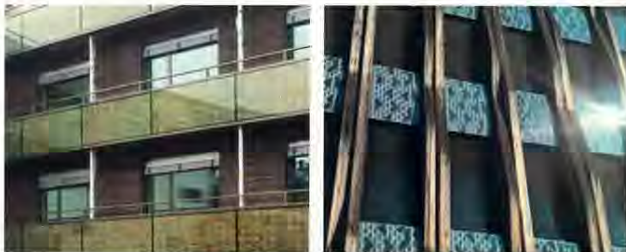
Links: polykristalline Photovoltaikzellen mit grüngoldbraunem Muster an einem Wohnhaus in Zürich (Kämpfen für Architektur); rechts: unterschiedlich gefärbte und angeordnete Zellen an der ConstructPV-Testfassade in Stuttgart (UNStudio).
