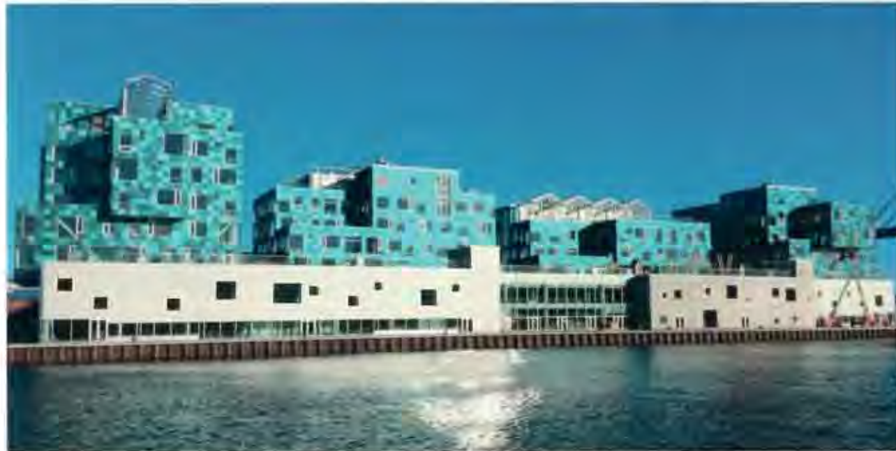
Oben links: Regionalbehörde in Rouen (Jacques Ferrier Architecture); oben rechts: La Seine musicale in Paris (Shigeru Ban Architects); unten: Internationale Schule von Kopenhagen (C.F. Moeller Architects) mit Photovoltaiktechnologie aus der Schweiz und einem Anerkennungspreis des Solarenergiefördervereins Bayern.
