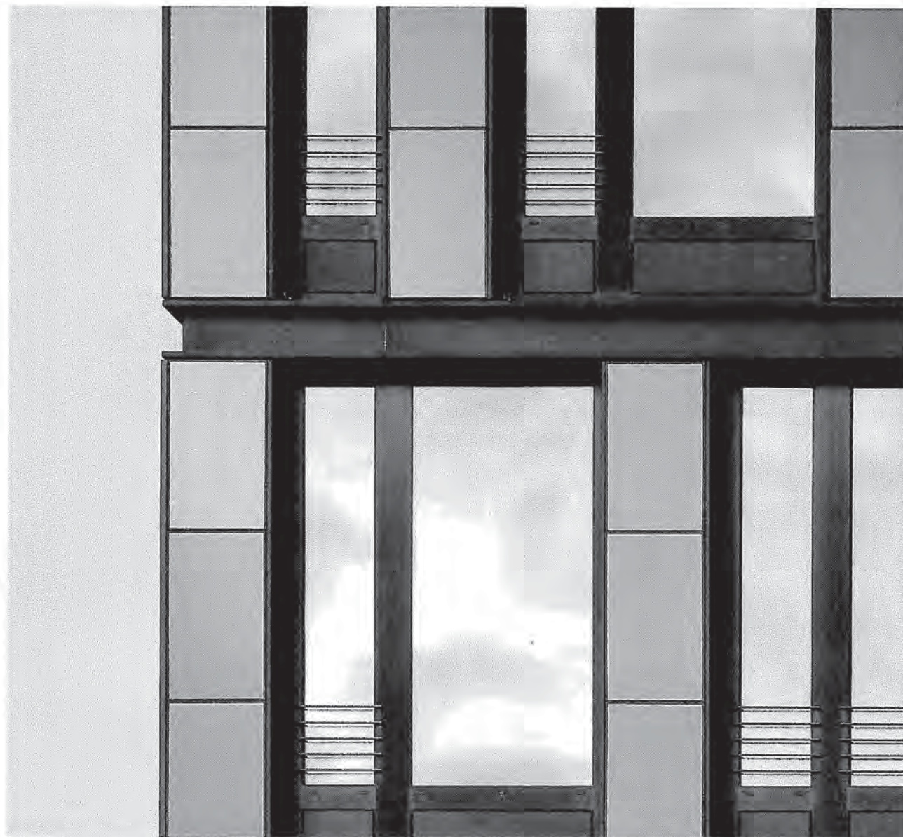
Teilansicht der Südfassade am neuen ZSW-Institutsgebäude in Stuttgart (Architektur: Henning Larsen). Die Dünnschicht-Photovoltaikmodule sind in die opaken Fassadenelemente integriert.
