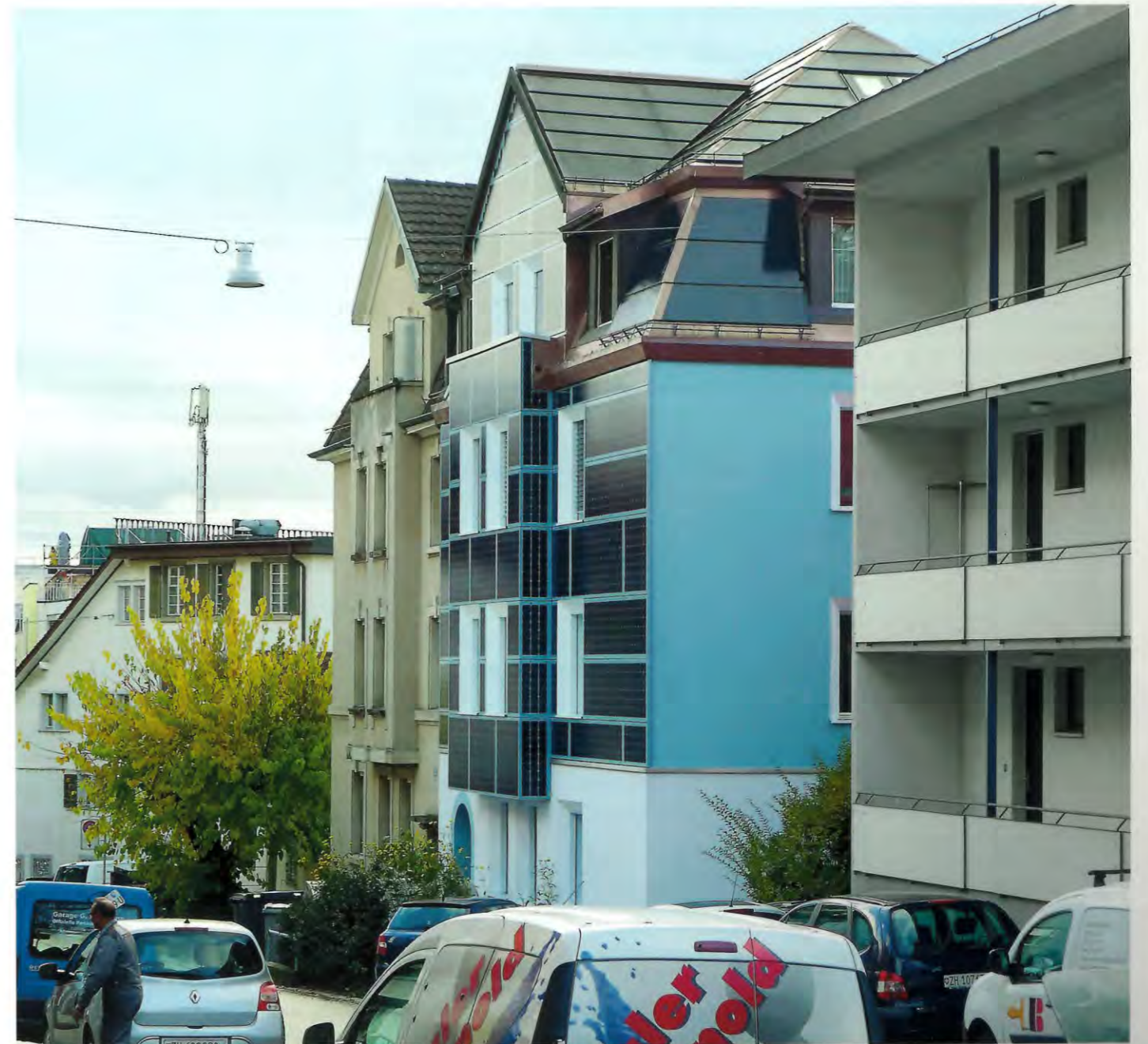
Gegebene Heterogenität im Kontext – Objekt Culmannstrasse 53 mit Nachbarbauten
