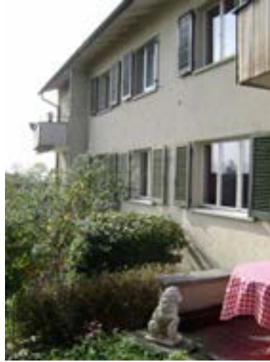
Fig. 2 Südostfassade vor Sanierung
