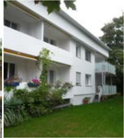
Fig. 10 Südwestfassade nach Sanierung
