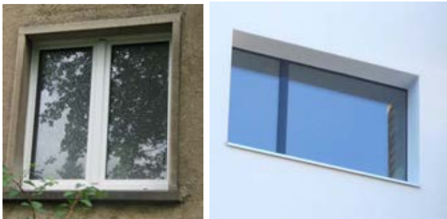
Fig. 20 Typ 1 Downtown , Standardfenster vor Sanierung und nach Sanierung
