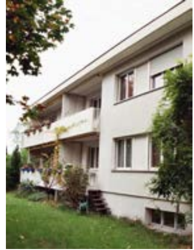
Fig. 3 Südwestfassade vor Sanierung
