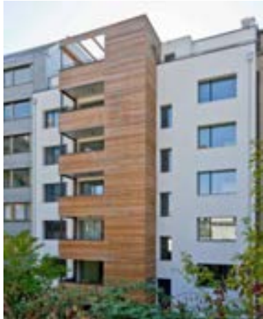
Fig. 8 Hoffassade nach Sanierung
