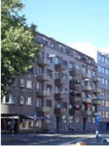
Fig. 1 Strassenfassade vor Sanierung
