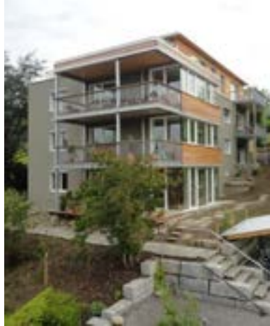
Fig. 9 Südwestfassade nach Sanierung
