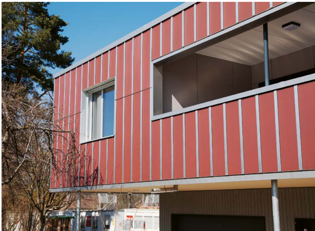
Die solare Fassade des Sport- und Freizeitzentrums Wallisellen setzt einen Farbtupfer und deckt den Eigenverbrauch ab.
