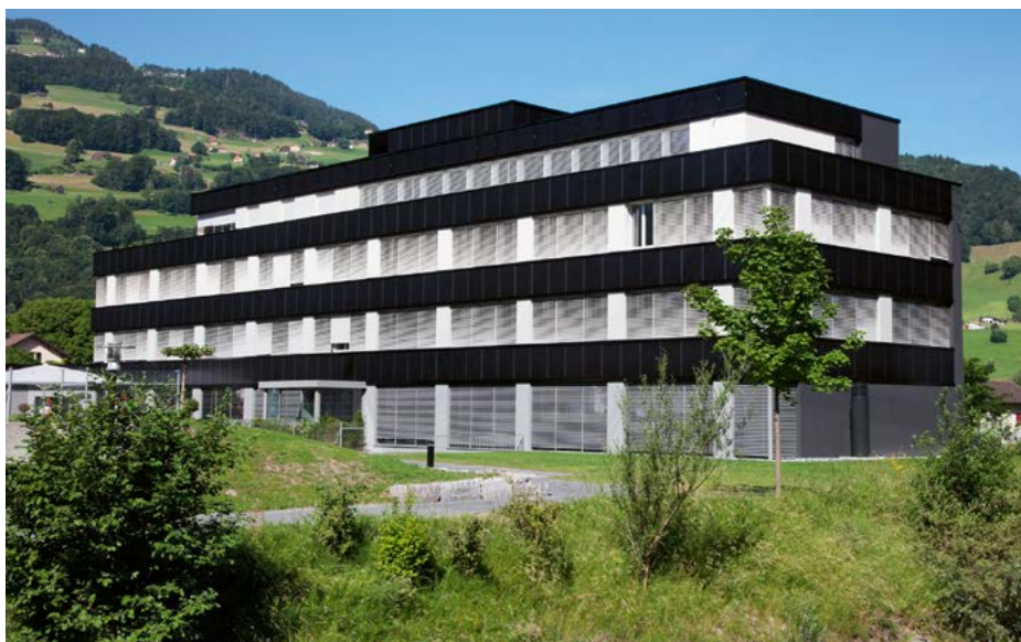
Wie hier bei diesem bald schon alten Solarklassiker in Flums könnten Bürohäuser vermehrt mit einer Photovoltaikfassade bestückt werden.
