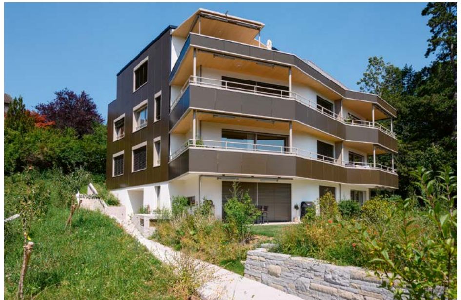
Wie hier in Zürich-Höngg eignen sich auch Mehrfamilienhäuser für ein Solarkleid an der Fassade.
