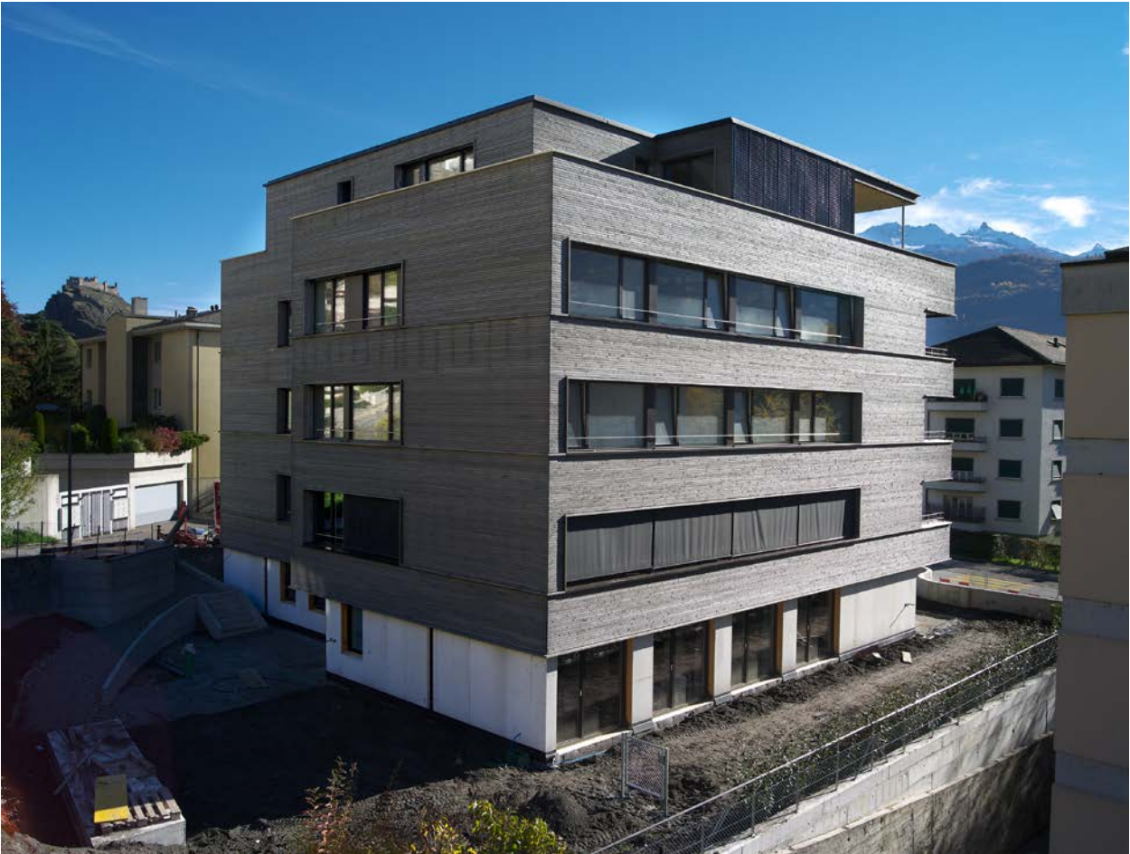
Le coffrage horizontal finement structuré reprend l'apparence poteaux-poutres en bois massif des anciennes maisons typiquement valaisannes.
