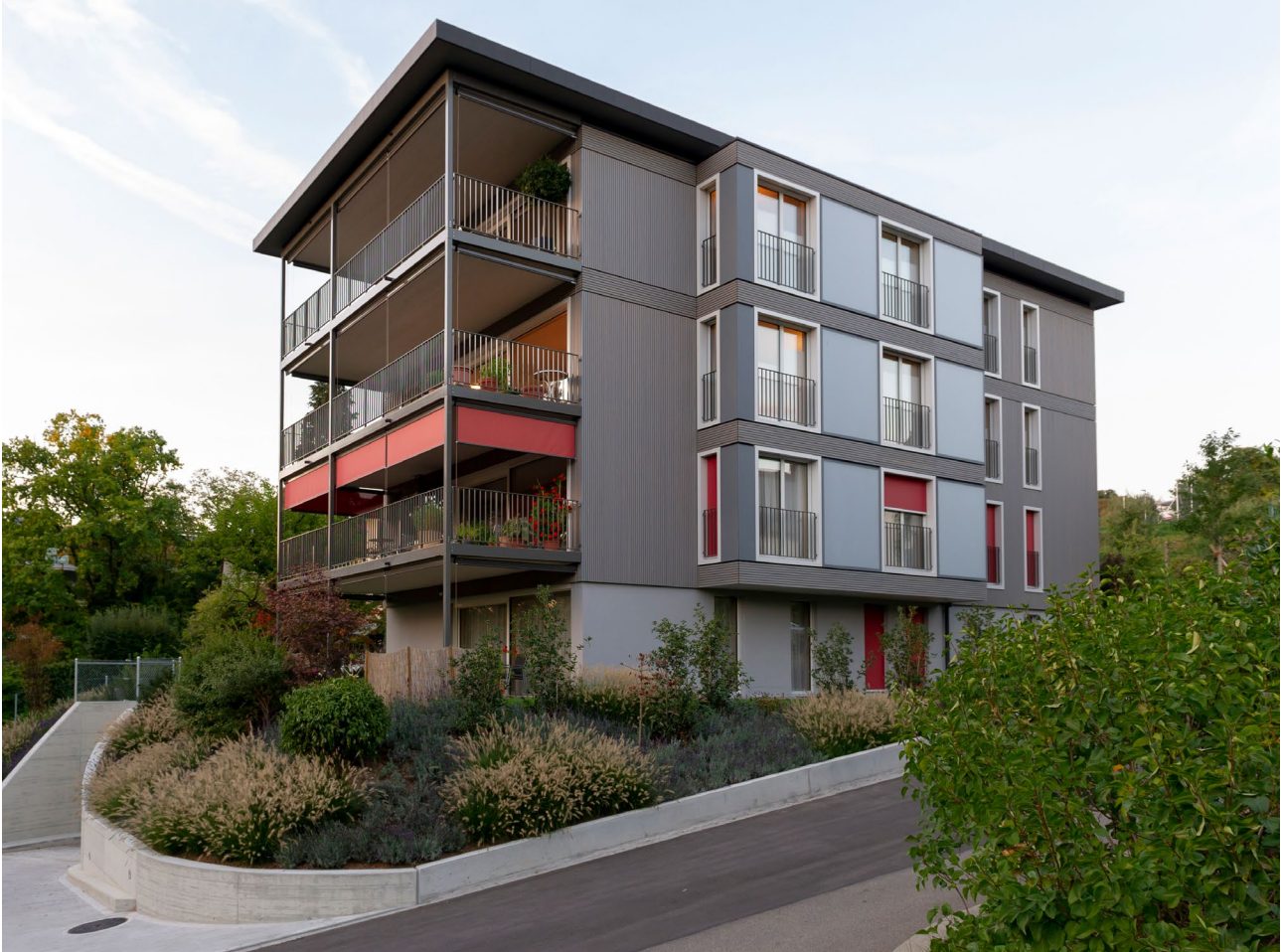
Mehrfamilienhaus Küssnacht mit grossen thermischen Sonnenkollektoren am Erker an der Südfassade, dachintegrierte Photovoltaik, Wärmepumpe mit Erdsonde, Null-Energie-Bilanz. Immeuble locatif à Küssnacht : grands capteurs solaires thermiques sur l'encorbellement de la façade sud, photovoltaïque intégrée aux toitures, pompe à chaleur avec sonde géothermique, bilan énergétique zéro.
